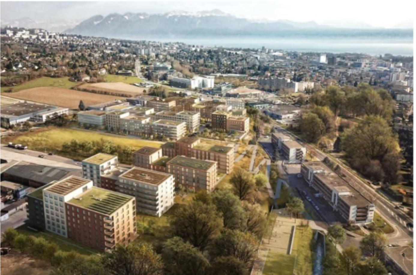
In Crissier realisiert das Unternehmen derzeit ein grosses Projekt (Bild: © Plazza)
