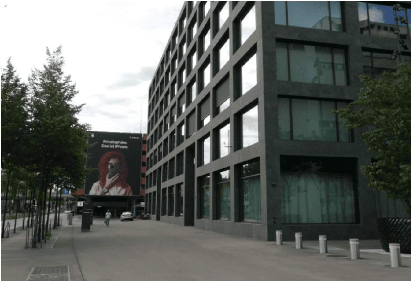
Dieses Gebäude auf dem Welte-Furrer-Areal ist bereits fertiggestellt (Bild: zVg)
